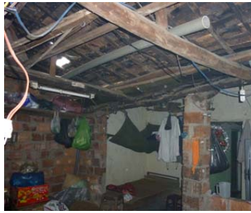
Bên trong nhà Đ T H : Rui nhà bị mục do bị thấm nước vì bị tụt mái trong những trận bão trước kia và nhà bị dột nhiều nơi.
