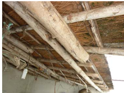
Rui & kèo nhà bị hư mục do mái bị dột khắp nơi.
