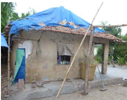
Nhà H T T bằng đất sét cũng đã bị thiệt hại nặng phải tạm dùng bache để che đỡ nắng mưa.
