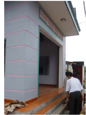
căn nhà Đ T H đã được hoàn tất.
